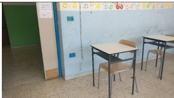
Figure 6-21 Esempio di vecchio cablaggio aule didattiche
