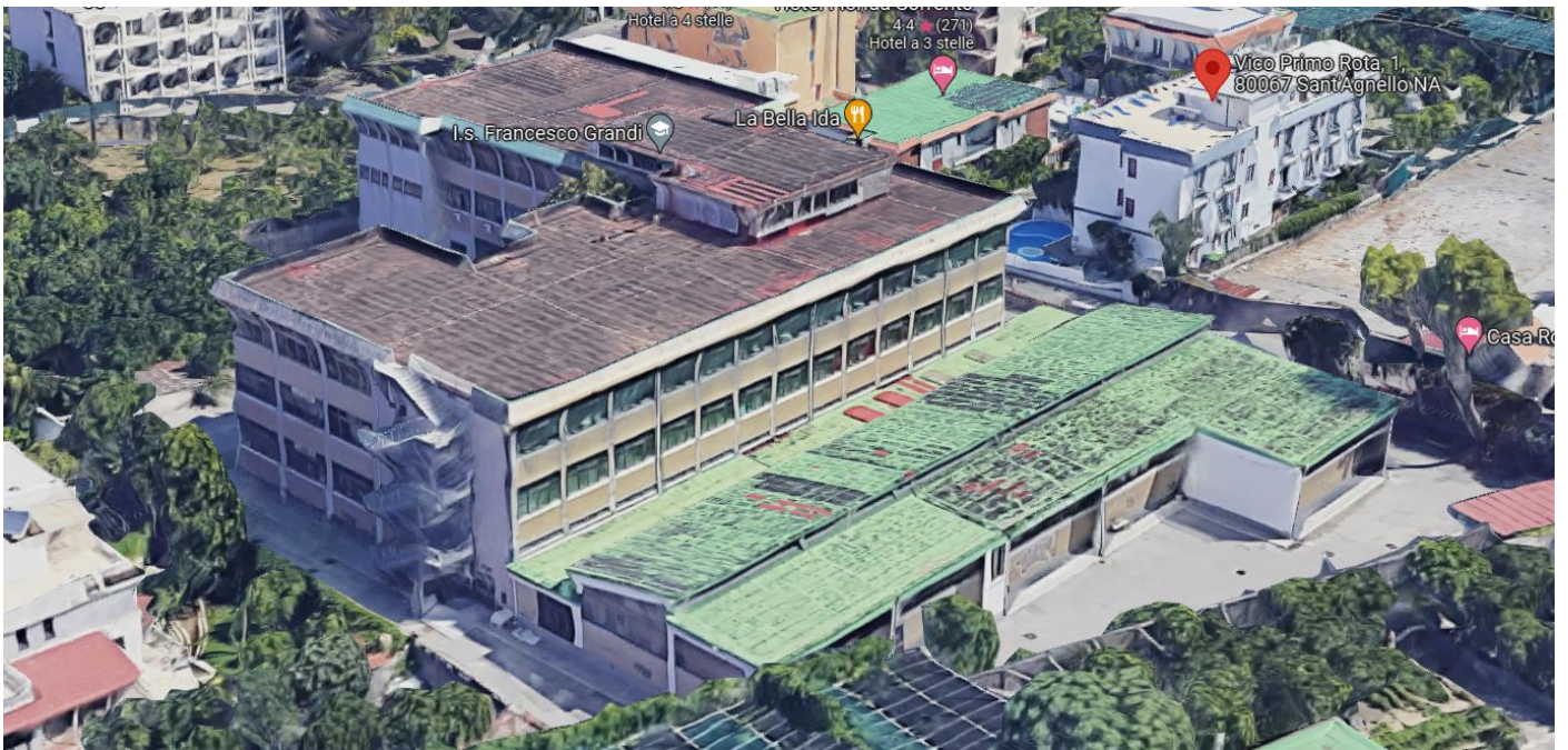
Figure 2-3 I.S. "F. Grandi", Sorrento (NA) – Sede Centrale - Vista Nord
