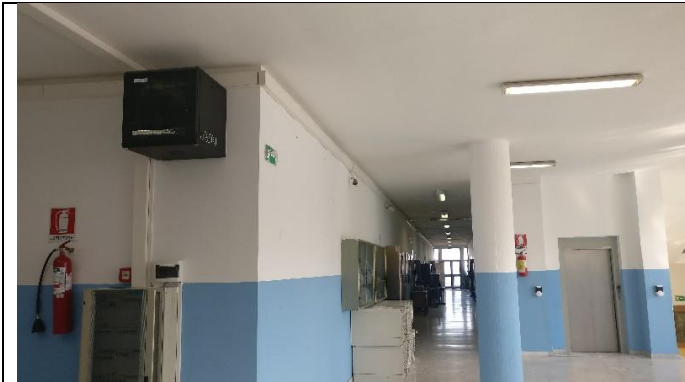
Figure 6-25 Rach con switch rete Wifi
